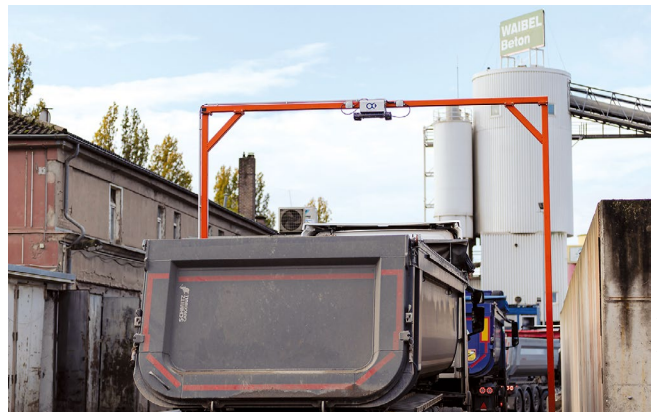
Bild 2: Erfassungsmodul im Feld: Optocycle Truck Imager über der Anlieferungswaage bei einem Betonwerk
